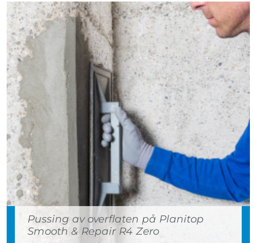
Påføring av Planitop Smooth & Repair R4 Zero
