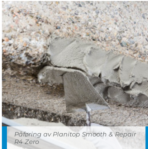
Pussing av overflaten på Planitop Smooth & Repair R4 Zero
